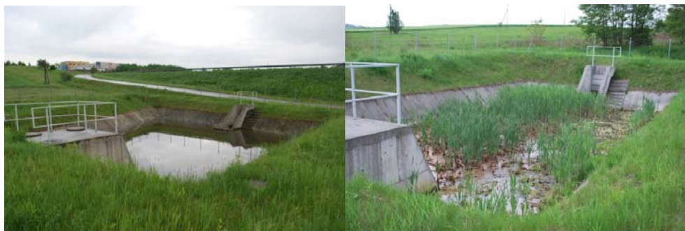
Ryc. 2. Zjazd z drogi nr 4 do zbiornika retencji ścieków opadowych oraz zbiornik porośnięty roślinnością [fot. B. Wiśniowska-Kielian]
