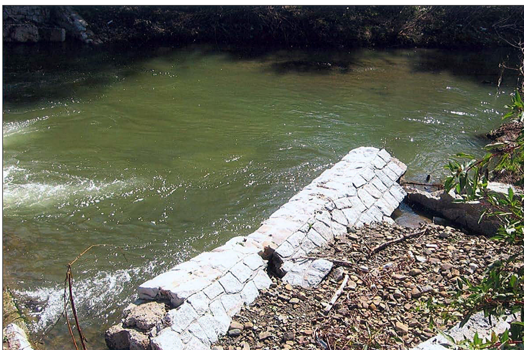
Fot. 3. Zniszczone umocnienia brzegów (Foto: Cz. Lipski) Photo 3. Devastated of floyd defenees
