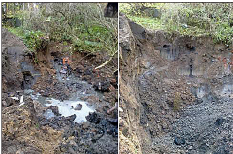
Fot. 2. Grunt w miejscu posadowienia nieszczelnego zbiornika po jego usunięciu. Widoczne przewody – odpływy ścieków do gruntu (fot. R. Nowak)
