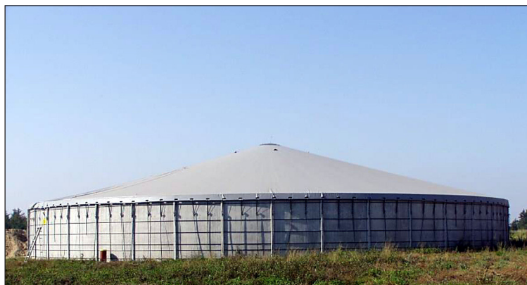
Rys. 1. Zamknięty zbiornik magazynujący gnojowicę (J. Dach) Fig. 1. Closed slurry storage tank (J. Dach)
