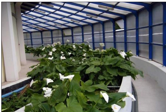
Fot. 1. Laguna hydroponiczna w oczyszczalni ścieków w Komorach Dąbrownych (fot. D. Bramowicz) Phot. 1. Hydroponic lagoon in Komory Dąbrowne WWTP (Phot. D. Bramowicz).
