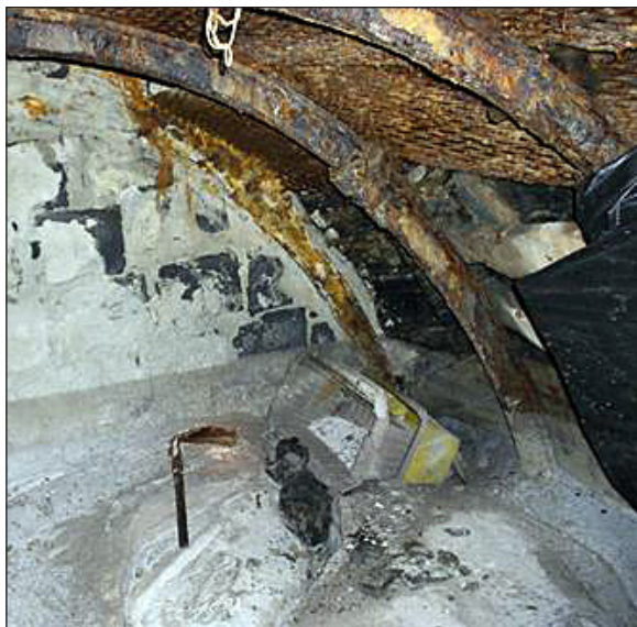
Rys. 3. Wypełnienie wyrobisk górniczych mieszaninami specjalnymi
