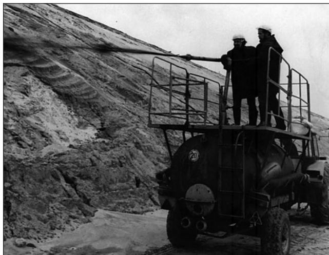
Fot. 6. Rozdeszczowywanie osadu ściekowego z nasionami trawy Photo 6. Sprinkling of sewage sludge mixed with grass seeds
