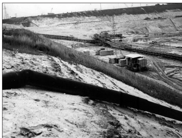
Fot. 7. Zwarta (darniowa) roślinność skutecznie chroni powierzchnię skarpy przed erozją Photo 7. Compact (turf) vegetation effectively protects the surface of the slope from erosion
