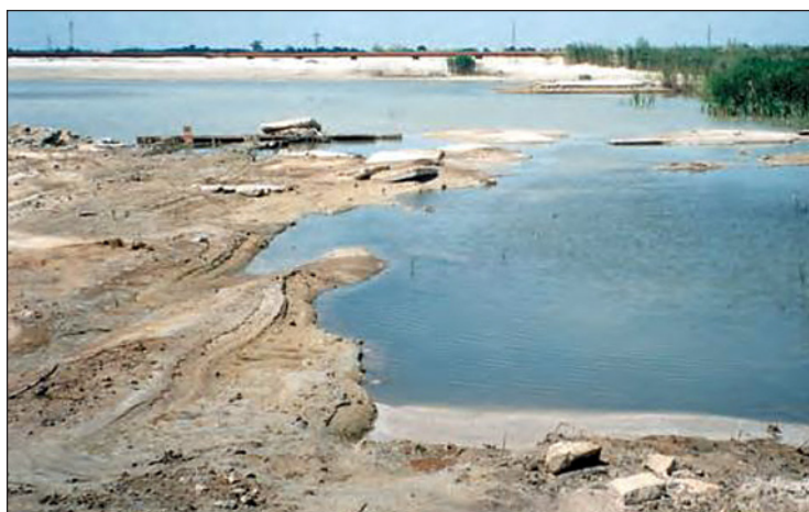
Fot. 11. Zawodniona niecka osiadania Photo 11 Water-filled subsidence basin
