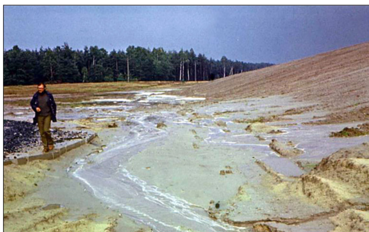
Fot. 8. Erozyjne przemieszczenie masy ziemnej na przedpole zwalowiska Photo 8. Erosive displacement of ground mass towards the foreground of the spoil tip
