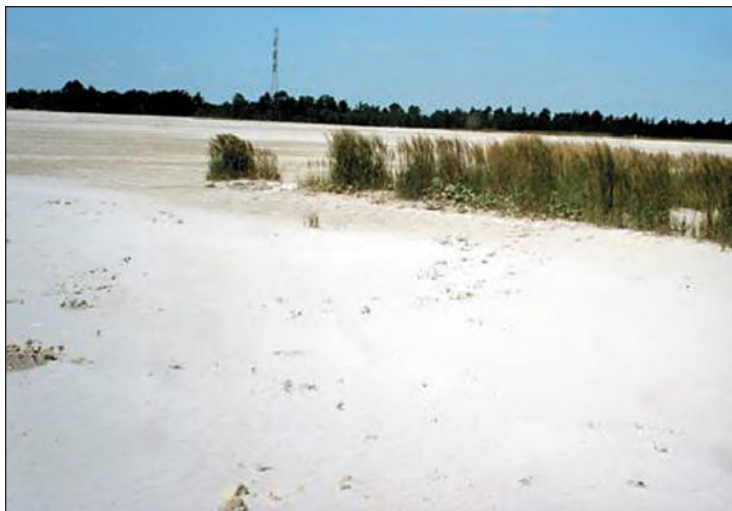
Fot. 12. Zawodniona niecka osiadania zabezpieczona wapnem poflotacyjnym – techniczna rekultywacja gruntu
