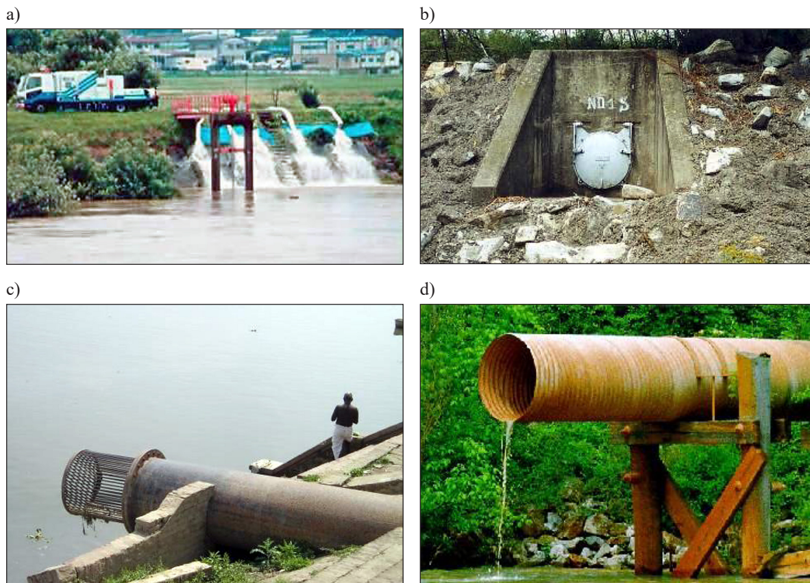
Fot. 1. a). Ruchoma przepompownia, b). wylot kolektora zrzutowego zabezpieczonego zaworem klapowym, c). zabezpieczony kratą wylot kolektora zrzutowego, d) niezabezpieczony wylot kolektora zrzutowego [www.environmenthamilton.org, www.exploit.com, www.fairfaxcounty.gov]
