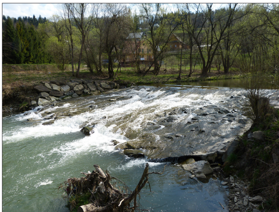
Rys. 2. Bystrze o zwiększonej szorstkości na rzece Rabie (fot. K. Plesiński)
