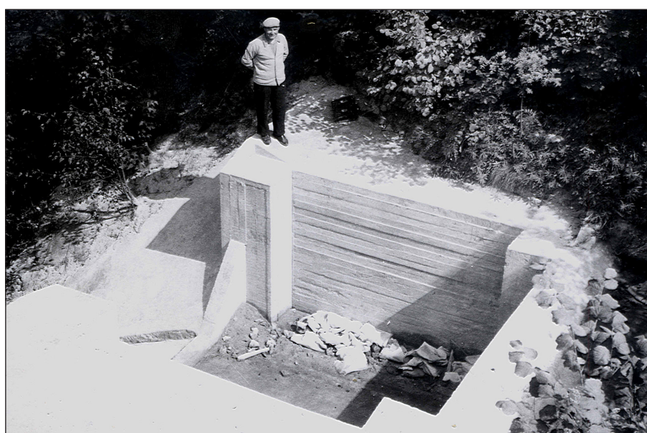
Fot. 2. Stopień skrzynkowy umacniający próg erozyjny (1964 rok)
