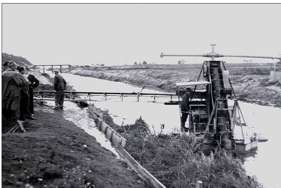
Fot. 1. Ujściowy odcinek koryta Sanny w trakcie bagrowania (1959 rok)
