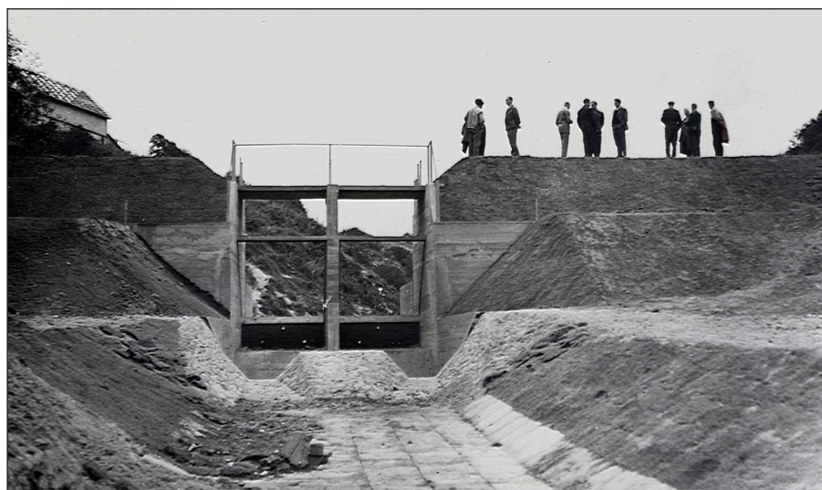
Fot. 4. Zapora przeciwrumowiskowa zamykająca wąwóz. Poniżej niej koryto odpływowe odprowadzające wodę przez stożek deluwialny
