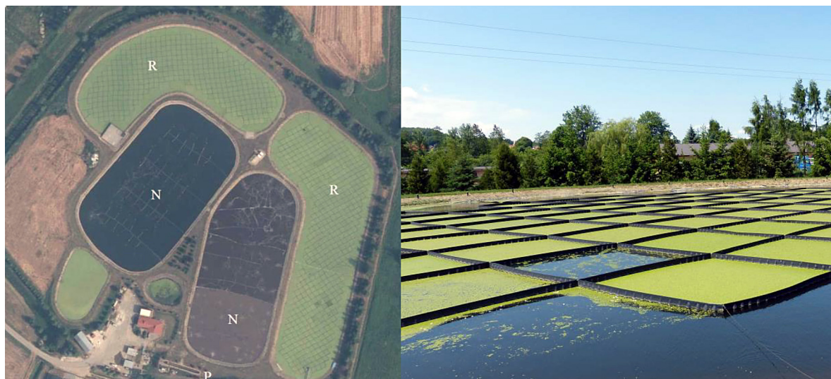
Rys. 1. Oczyszczalnia typu Lemna w Chmielniku: P- piaskownik, N- stawy napowietrzane, R- stawy roślinne; widoczne charakterystyczne profile z tworzywa sztucznego, utrzymujące roślinność i ułatwiające jej zbieranie (źródło: geoportal). Po prawej widok na staw roślinny (fot. K.Winiarska)
